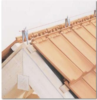
soir. La hauteur de la latte de rehausse doit être telle que la tuile faîtière fixée ultérieurement sur la latte dépasse de quelques millimètres la surface des deux rangées de tuiles hautes de part et d'autre du faîte.
